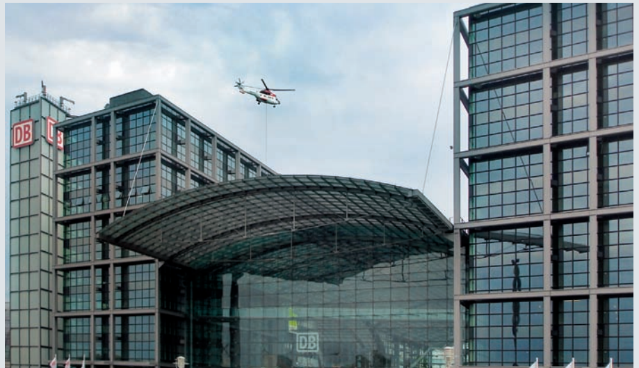
Bügelbauten Berlin – Einbringung der Zentralklimageräte per Helikopter
